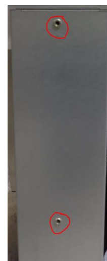
Figur 6 Fiberkabelskåp som visar vilka hål som ska användas vid hopsättning med kraftkabelskåp.
