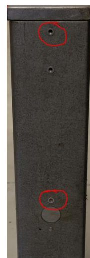
Figur 5 Kraftkabelskåp där de markerade hållen ska användas vid hopsättning med fiberskåp.
