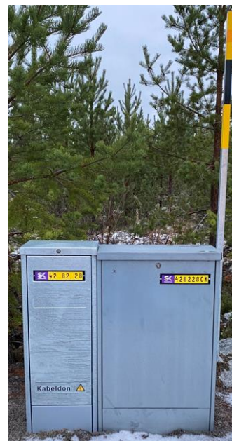
Figur 1 Kraftskåp som är ihop skruvat med ett fiberskåp. Med en plogpinne på högersida.
