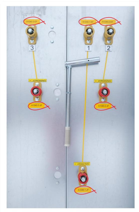
(Norrmontage AB, ID-märkning manöverfack)
