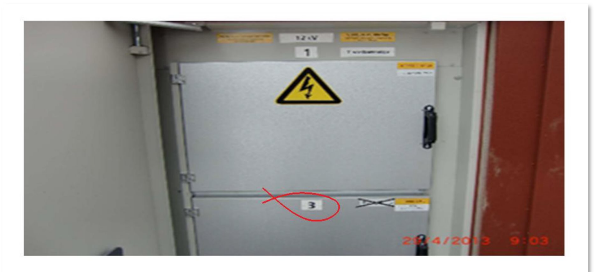
(Holtab, fackmärkning seriesatellit)
