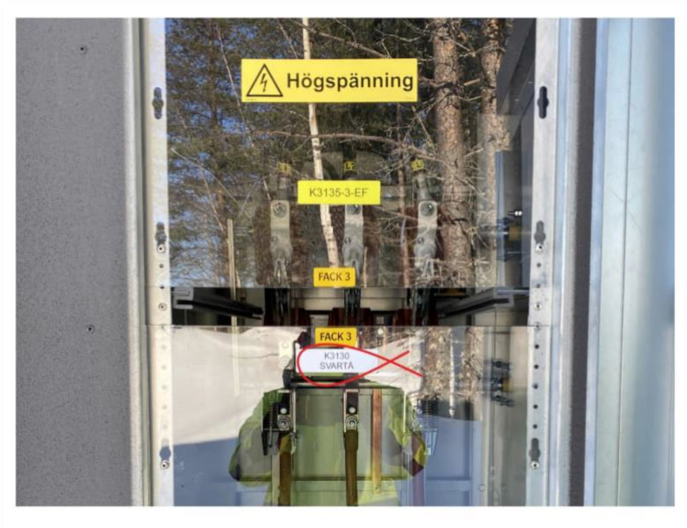
(Norrmontage AB, adressmärkning i högspänningsfack på nedre plexiglas)
