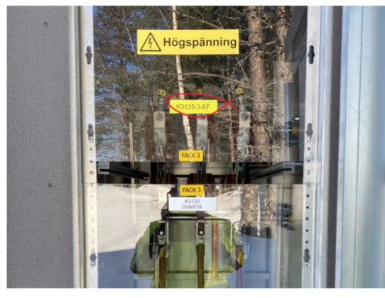
(Norrmontage, ID-märkning HSP-fack med plexiglas)
