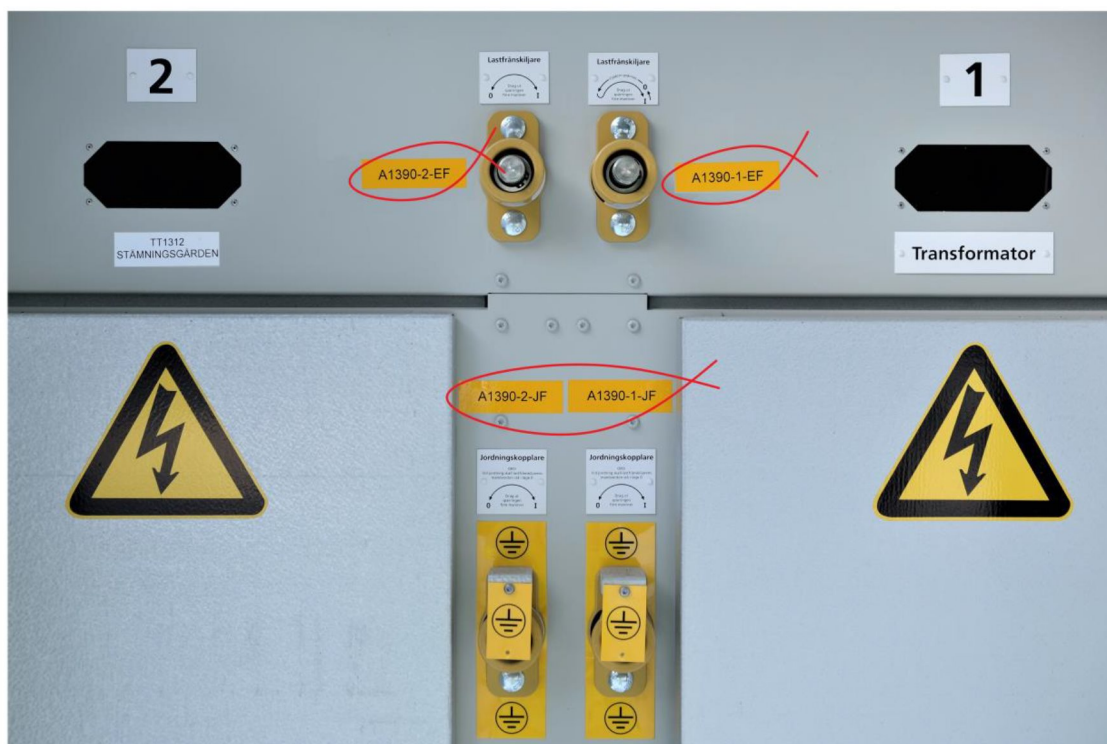
(Holtab, ID-märkning i högspänningsfack)
