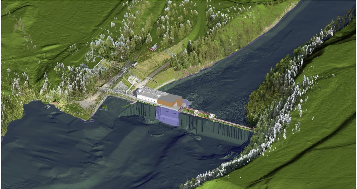
Figur 4. Lokalisering av ny stationsbyggnad i Granfors. Vy från uppströmssidan, ny stationsbyggnad i brunt till höger om befintlig stationsbyggnad..
