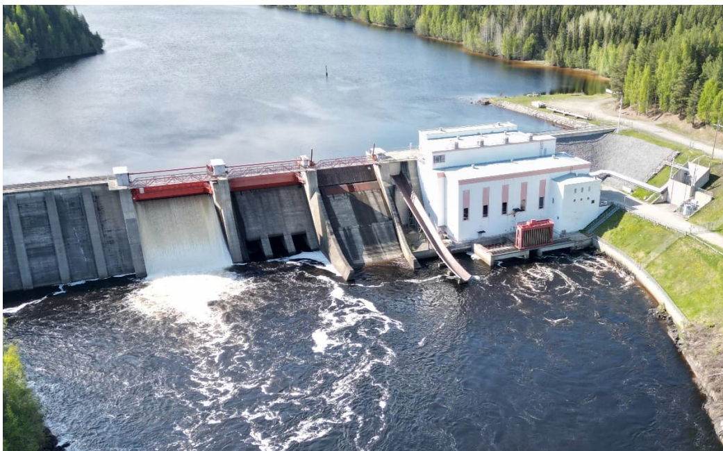
Figur 3. Granfors vattenkraftverk från nedströmssidan. Det gamla flottningsutskovet och sektorutskovet syns i mitten av bilden.
