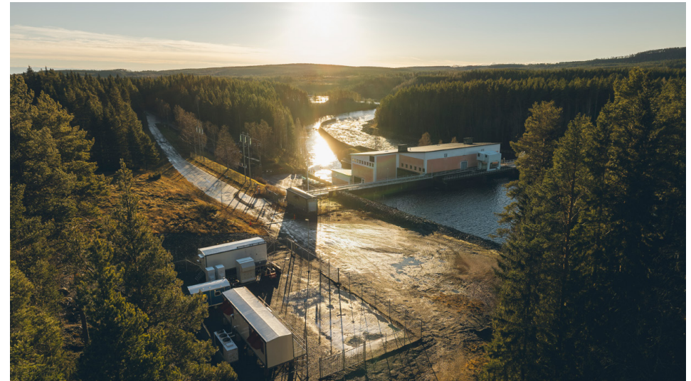
En ny batterianläggning vid Båtfors vattenkraftverk bidrar med kapacitet och utjämning av belastningstoppar i elnätet
